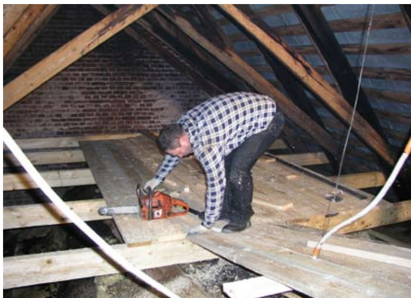
Montaż podestu na guano nietoperzy chroniącego strop kościół (R.S.)
