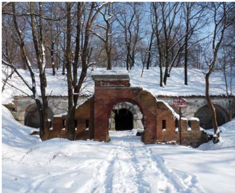
Brama fortu z ceglany murem oporowym (D.R.)
